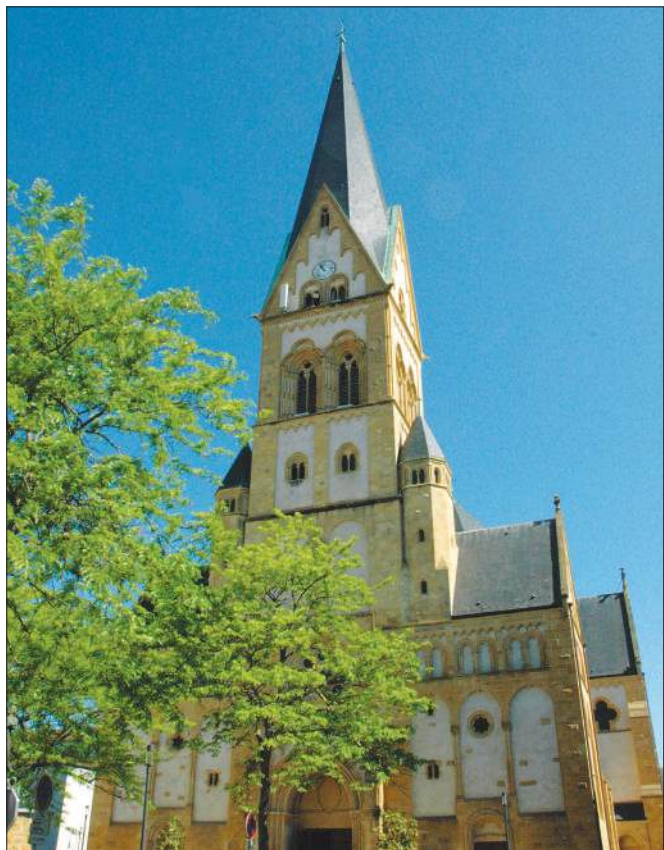
L'église St-Joseph de Montigny-lès-Metz.
